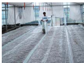
③ 重し用OKホース設置。
