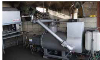
排熱を再利用して蒸気を高温にするボイラー本体。
